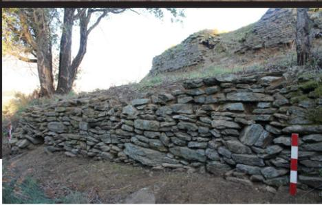
bloços, sobretudo na base da muralha, que têm como função conferir uma maior resistência à estrutura. Estas três linhas de muralha foram erguidas em socalco, adaptadas ao relevo, usando como matéria-prima o xisto, revelando uma construção por circuitos defensivos concêntricos, com diversas linhas de muralha adossadas, compondo patamares contínuos.
